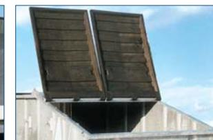
Zusätzliche Öffnungsvergrößerung über Scharnierblech - zur besseren Entleerung
